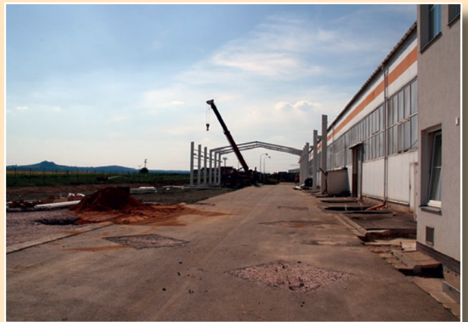
STAVBA NOVÉ HALY
